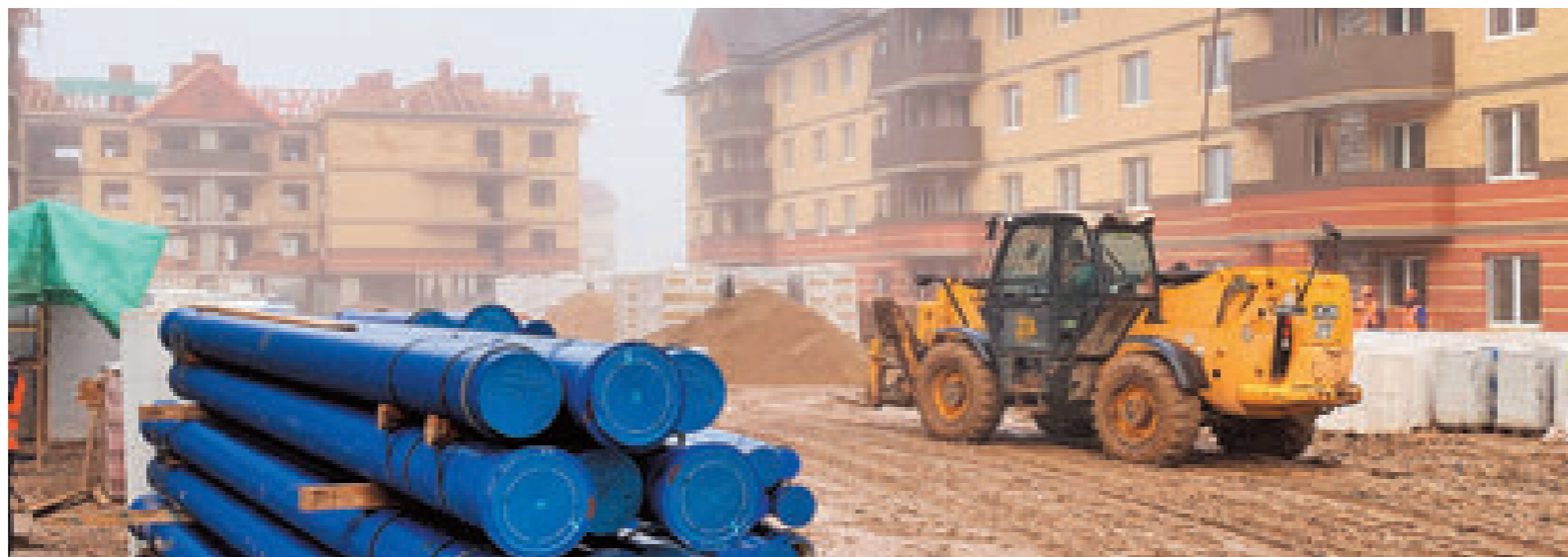
▲ Строительство ЖК «Восточный»
